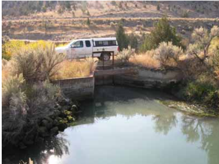
Vigilante Canal headgate
